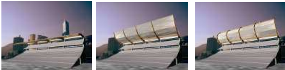
Cubierta plegable para una gradería
